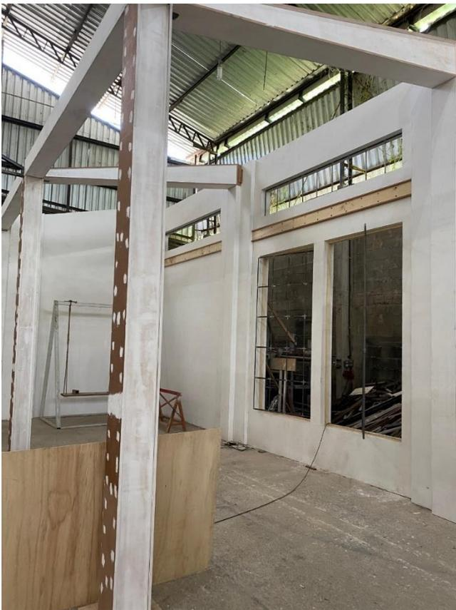
Figura 67 – Pré-montagem vista dos pilares e janelas. Fonte: arquivo pessoal.
